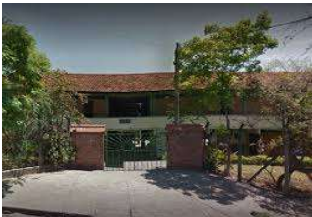
Entrada da Escola Estadual Íldio da Costa.
