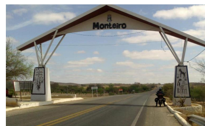
Portal de entrada do Município
