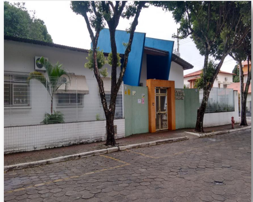
Fotografia 1: Fachada da escola
